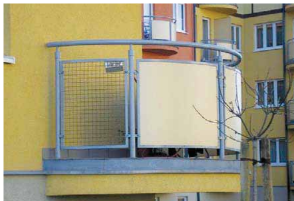
Rys. Montaż płyt balkonowych.
