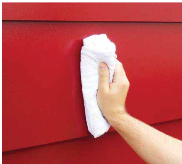
Rys. Czyszczenie paneli Krono Siding.
